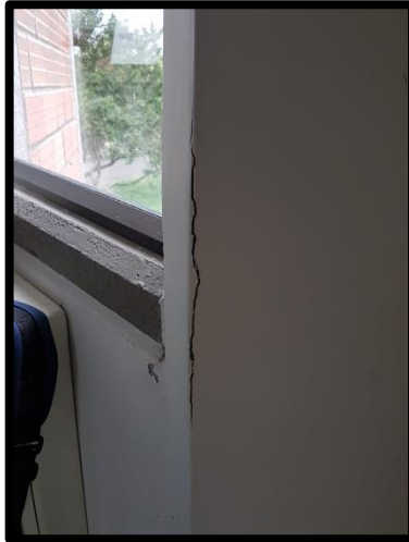
Agrietamientos y telarañas prominentes en la pared
